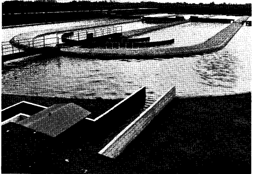
Afb. 2 - De oxydatiesloot bij „West-Friesland” te Lutfjewinkel. In de scherpe bochten zijn geleideschotten aangebracht. De circuits worden gescheiden door dijken met een kruinbreedte van 2 m. Capaciteit ruim 12.000 i.e.
