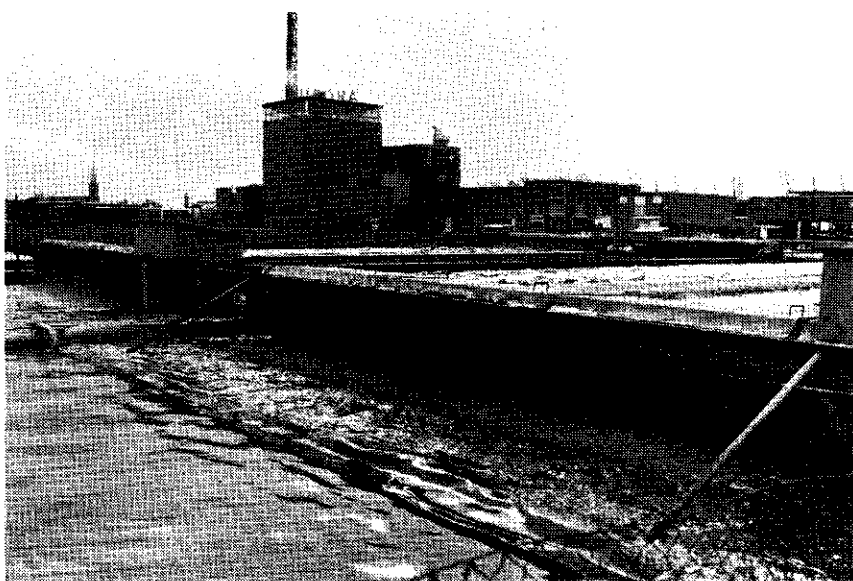
Afb. 6 - De beluchtingsrotoren te Opmeer. In het binnenste circuit zijn 2 rotoren van elk 5 m opgesteld, in het buitenste circuit 2 rotoren van elk 6 m werkzame lengte.
