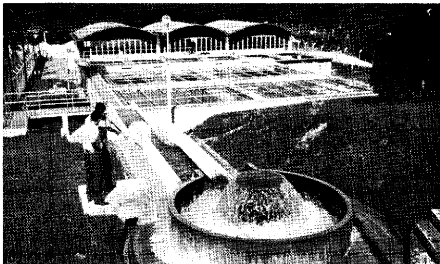
Afb. 35 - Watervalbeluchter voor beveiliging tegen terugstromen.
