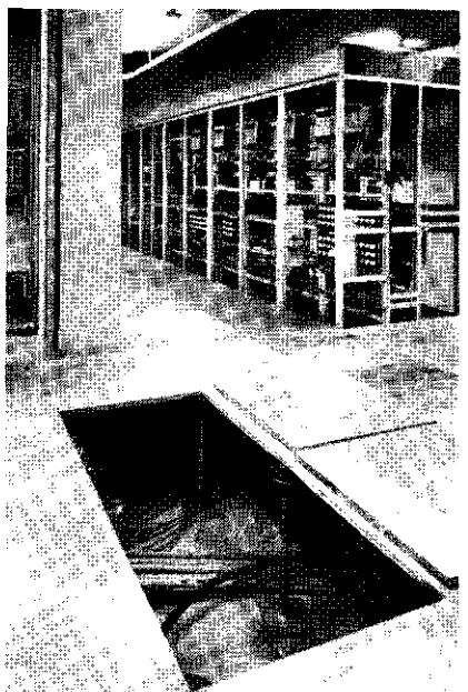
Laagspanningsschakelruimte met kabelvloer.
