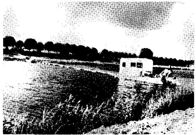
Abb. 8 - Saugbagger zur Reinigung der Beckensohle.
