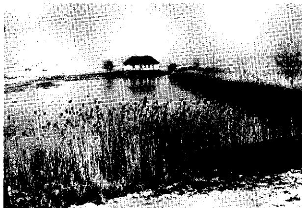
Abb. 7 - Anreicherungsbecken der Wassergewinnung Wiesbaden-Schierstein.
