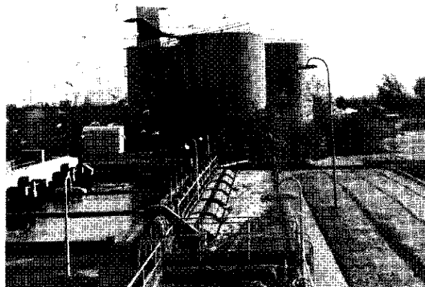
Afb. 8 - Slijkindikkers tweede trap met op voorgrond voorbezinktanks en beluchtingsborstels.
