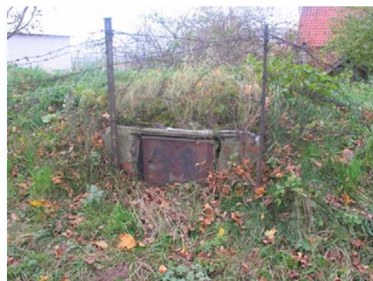
Aardappelkuil in de dijk
