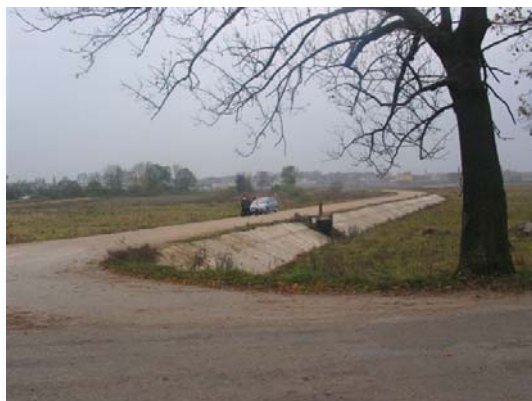
Afwateringssluisje in de dijk
