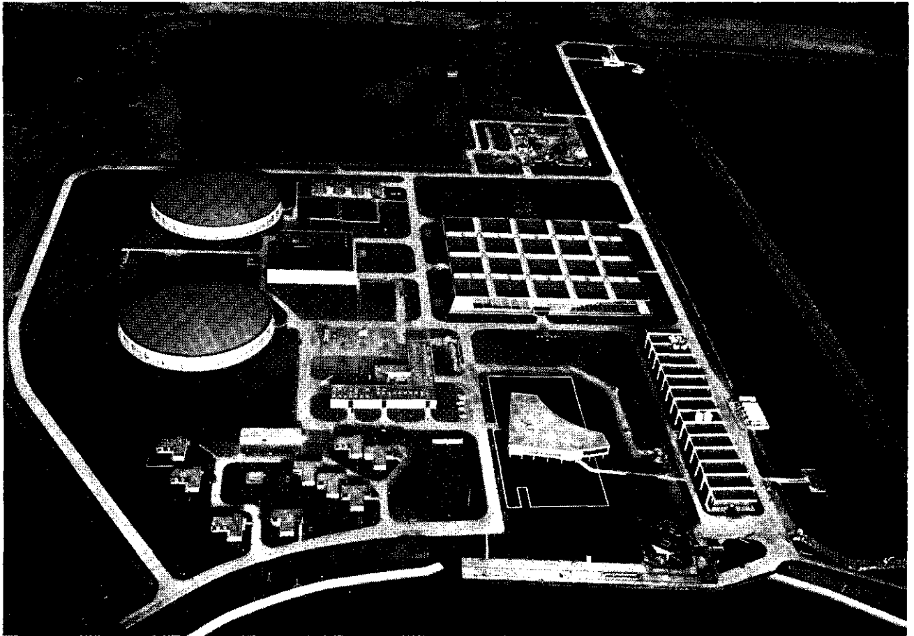
Een recente luchtopname van „De Berenplaat”, het waterwinwerk van de Drinkwaterleiding van de Gemeente Rotterdam.
