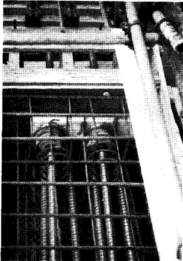
Afb. 9 - Detail horizontale voorspanning.
