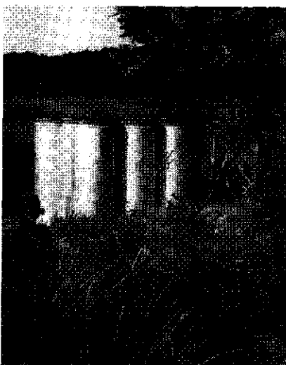
Afb. 3 - Unit met zes infiltratieketels nabij de Oranjekom.
