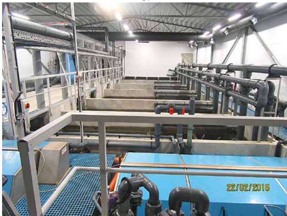
De hal waar de waterbehandeling plaats vindt. Aan de voorzijde is een deel van de trommelfilters te zien met daarachter 6 semi-floating bed filters.
