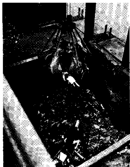
De grofbunker met grijper.
