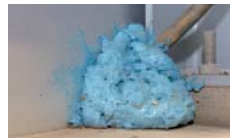
Flexibele pur Als er veel naden en kieren zijn, dan is het tijd voor de pur-bus. Neem flexibele pur.
