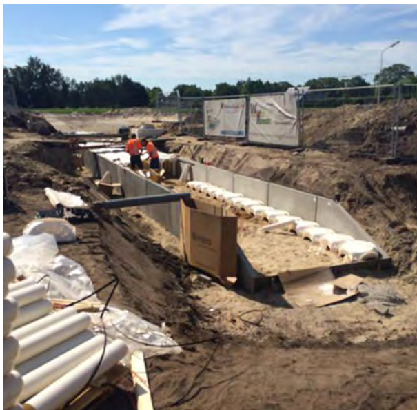
Aanleg faunadiuiker met verloren bekisting (bron: Mark Vissers)
