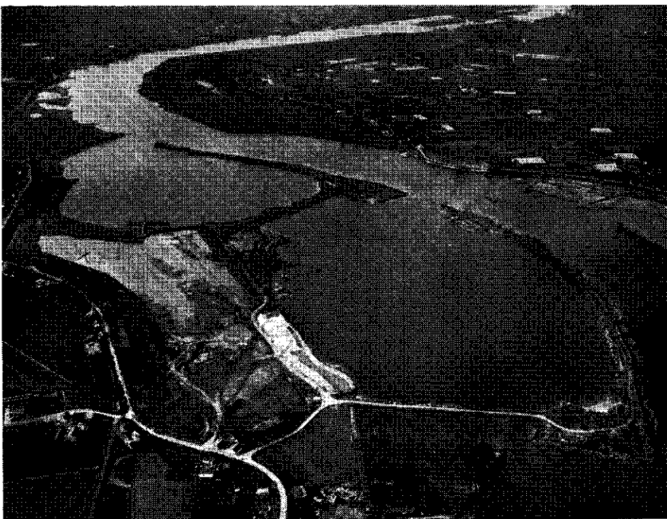
Deze afgedamde zijtak van de Maas, het Andelse Bekken, zal dienst gaan doen als natuurlijk spaarbekken voor de drinkwatervoorziening van Den Haag.
