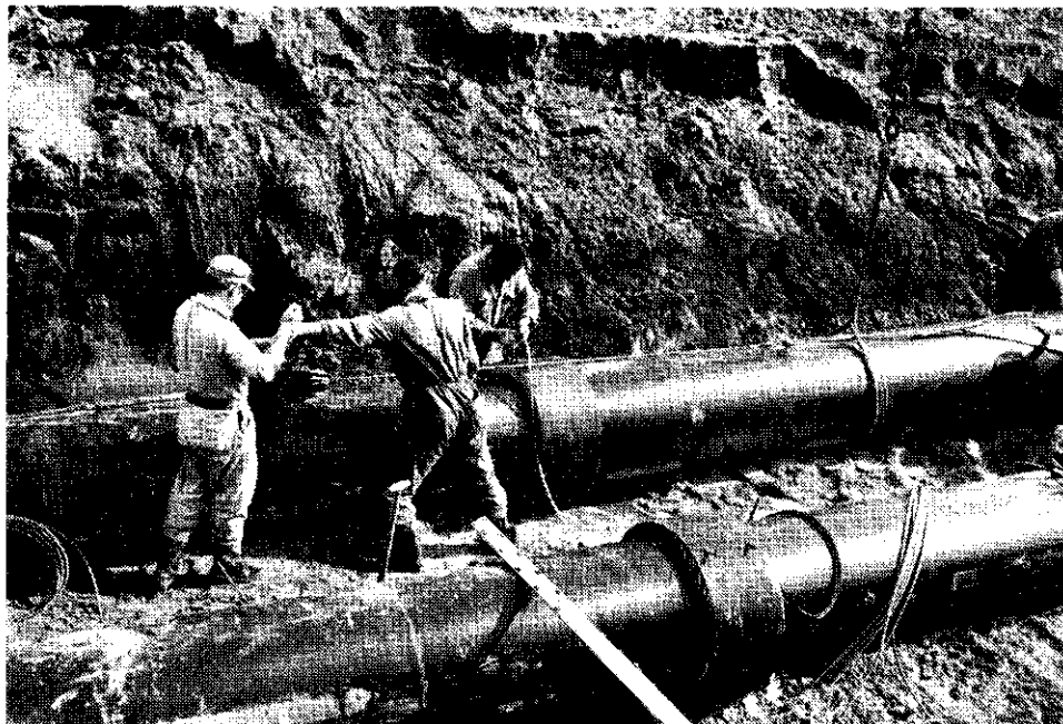
Het monteren van een trekvast koppel voor een zinker Ø 600 mm.
