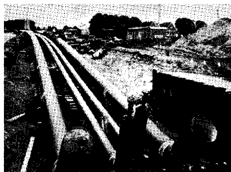
Bild 6 - Düker-Verlegung NW 800 mit ZM-Auskleidung für Trinkwasser.
