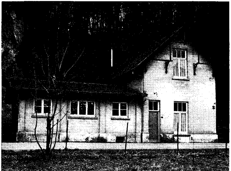
Afb. 4 - Buitenaanzicht van het pompstation Geulhem.
