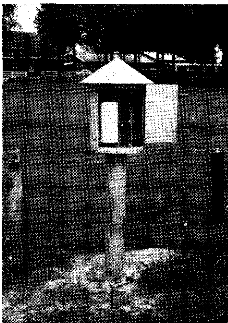
Afb. 2 Een registrerende grondwaterstandmeter.
