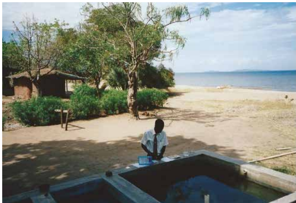
Betonnen bassin met PVC pijp aan de rand van Lake Malawi
