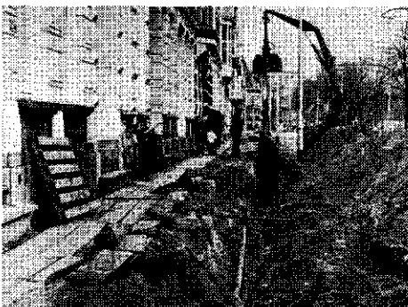
In de opengegraven sleuf heeft men zojuist een buisleiding verwijderd. Een kabel is tijdelijk terzijde gelegd om ruimte te maken.
