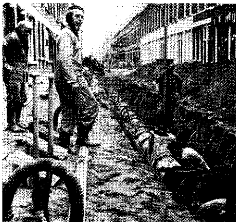
Aanleg van een rioering. Links op de voorgrond is een bronbemaling zichtbaar, waarmee de 'put' wordt drooggehouden. De man rechts op de foto is behulpzaam bij het 'zichten', d.w.z. de hoogtebepaling van het riool.
