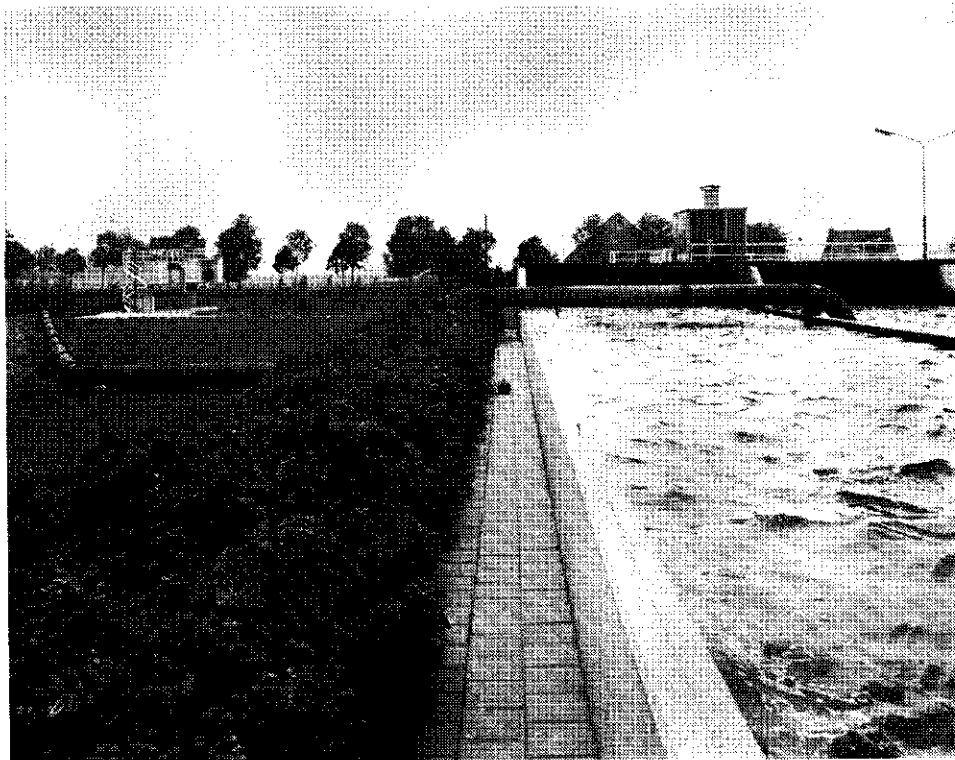
Kortsluitleiding aanvoerverdeelwerk, circuit RZI Beemster.
