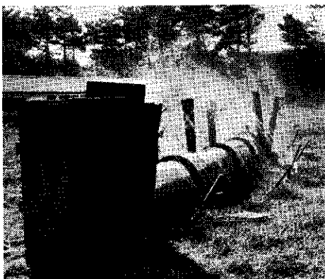
Afb. 2 - Proefopstelling van \varnothing 300 \text{ mm} asbest-cement zuigleiding.
