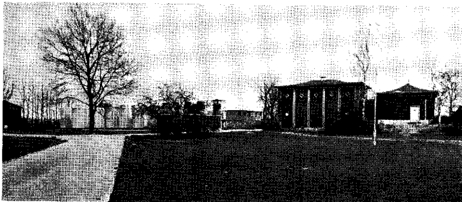
Overzicht pompstation Engelse Werk.
