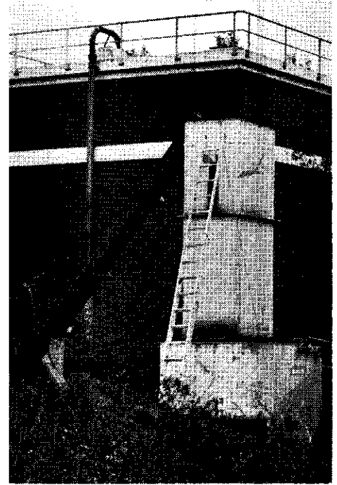
De Biopac-proefinstallatie met o.a. oxydatiebed (bovengedeelte) en bezinkingstank (ondergedeelte).
