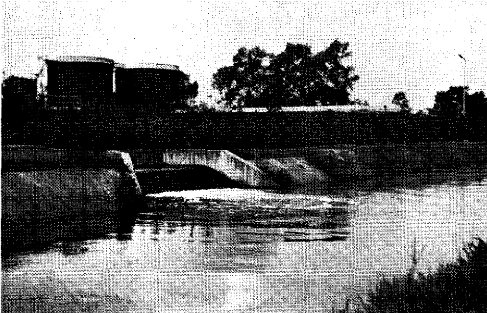
Afb. 12 - De lozing van effluent over een overstortdremmel in het kanaal.
