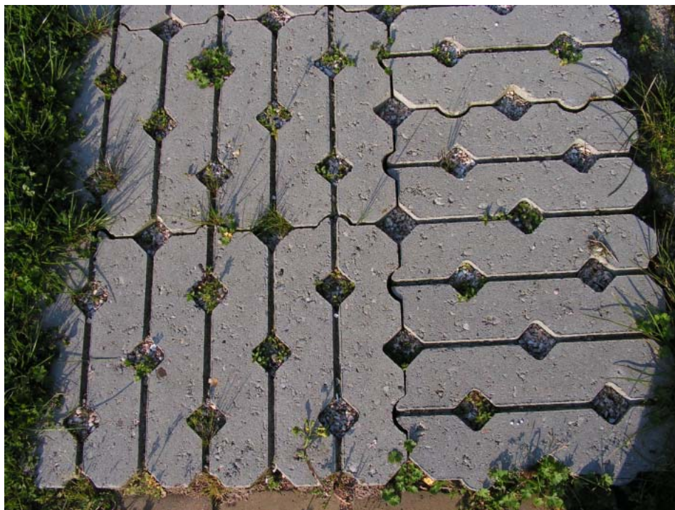
Rona blocks (RB), twee jaar na aanleg.
