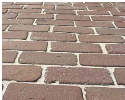
Afbeelding 4. Streetprotection voegvulling van Pressplate®. Foto: Pressplate® 2004.
