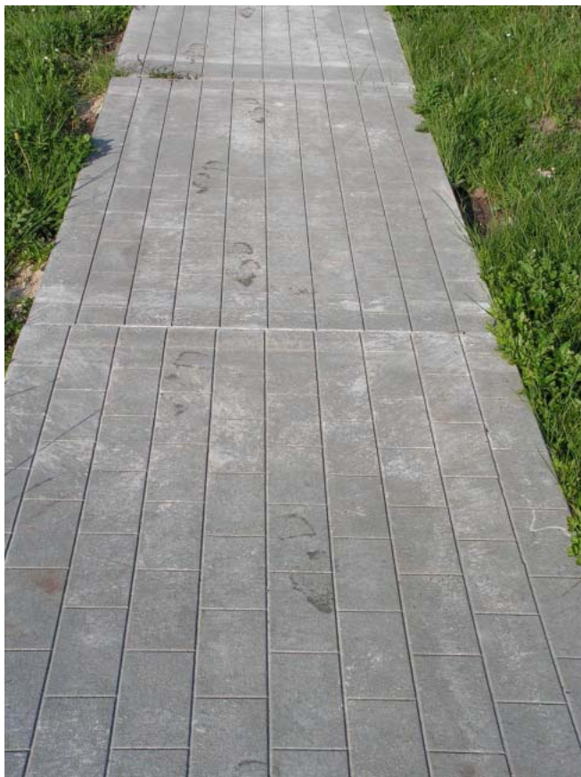
Betonplaten (EV), één jaar na aanleg.
