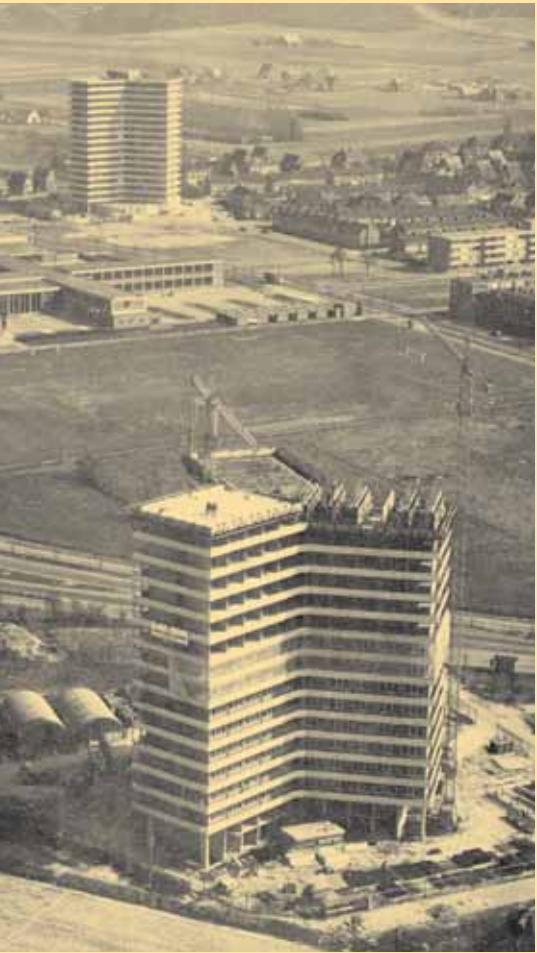
'Mannenflat' Hoevenstein in aanbouw. Op de achtergrond staat Asserpark, waarvan de bovenste vijf verdiepingen gereserveerd waren voor vrouwen. / foto Idealis
