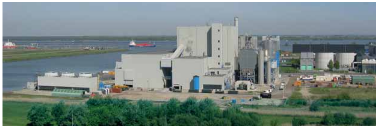
De mestverwerkinginstallatie in Moerdijk verwerkt jaarlijks 440 duizend ton mest van kippen en kalkoenen.
