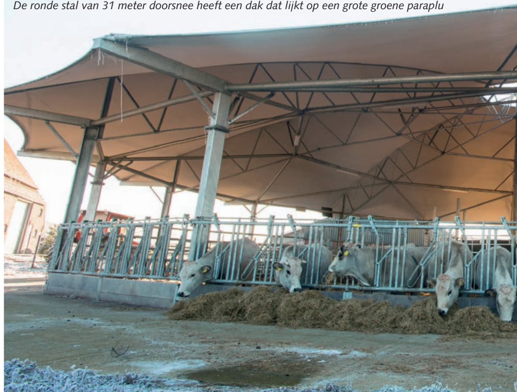
De ronde stal van 31 meter doorsnee heeft een dak dat lijkt op een grote groene paraplu
