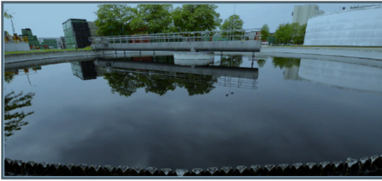
Door een mechanisch roerwerk te installeren bleek het mogelijk om de productie van biogas te verhogen en de hoeveelheid stikstof in het gezuiverde afvalwater met ruim 80% terug te brengen. Deze verbetering is door HEINEKEN als 'global best practice' aan brouwerijen wereldwijd gepresenteerd.
