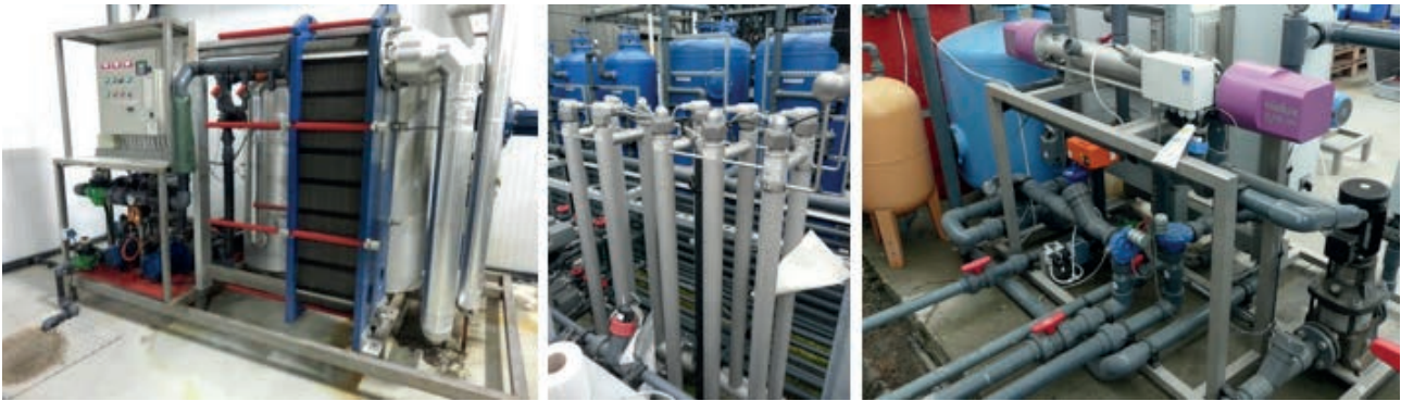
Figuur 8 Ontsmettingsinstallaties: verhitting (links), lage druk UV (midden), hoge druk UV (rechts).
