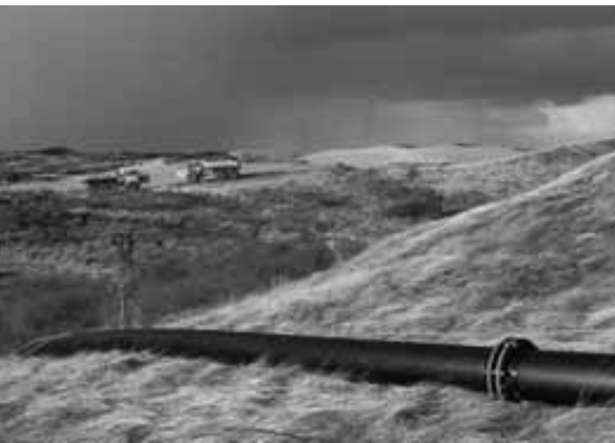
Maatregelen voor verstuiving: reactivering Bruid van Haarlem 2002/2003. De leidingen in beeld zijn voor hydraulisch zandtransport om nevenschade aan de omgeving door vrachtovervoer te verkleinen.
