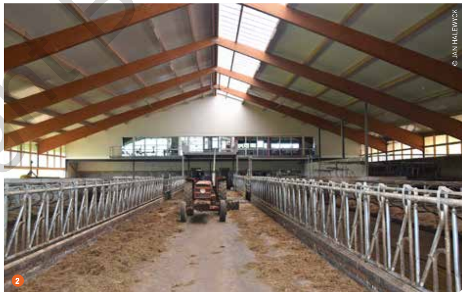
1 De luchtwasser staat buiten, aan het einde van de stal. Links en rechts van de poort is de opvang van de dikke fractie te zien. 2 De melkstal met houten spanten zonder steunpilaren zorgt voor een open beeld in de stal. Achteraan de stal zijn de vergaderruimtes te zien die uitgeven op de stal.
