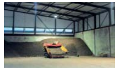
Drukvaste wand Betonpanelen worden in toenemende mate ook gebruikt als drukvaste wand.
