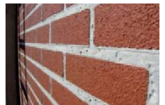
Steenmotief Steenmotieven worden gemaakt met gekleurd grind, poeder of een laagje gekleurd beton.
