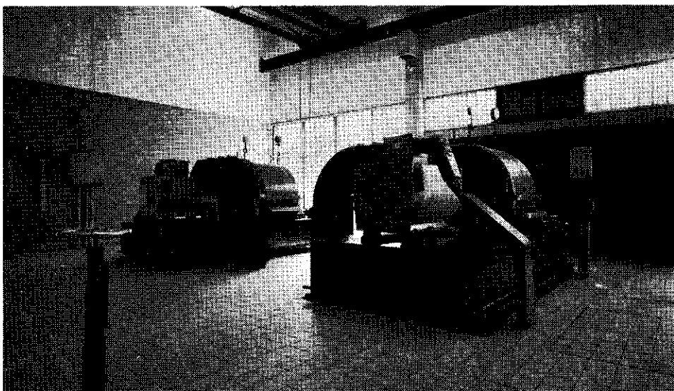
Afb. 9 - Centrifugaalkompressoren op r.i. West in Amsterdam. Op de achtergrond de omkasting van de luchtfilters.
