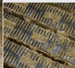
Een rubberen ondergrond bevordert het koecomfort, de composietblokken zorgen ervoor dat de klauwen toch voldoende slijten.
