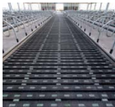
Een nieuwe stal met MeadowFloor. De composietblokken zijn groen.
