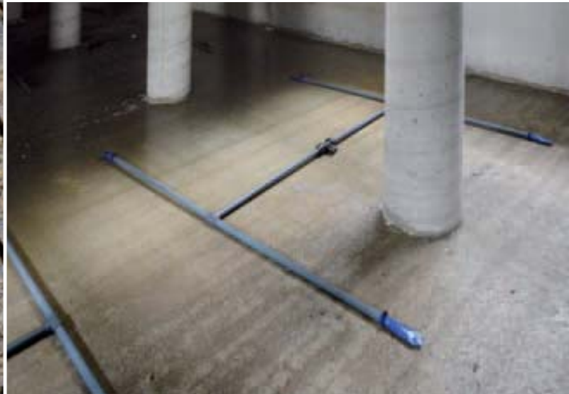
Aeromix reduceert de ammoniakemissie door luchtballen in de mest te blazen. Het werkt, maar we weten niet hoe. Dijksema wil wetenschappelijk inzicht.
