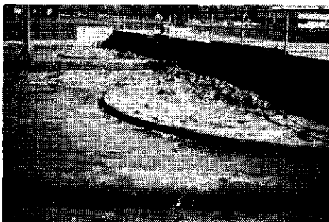
Afb. 1 - Een van de twee beluchtingsbassins op de rioolwaterzuiveringsinstallatie Blumental bij Wenen.
