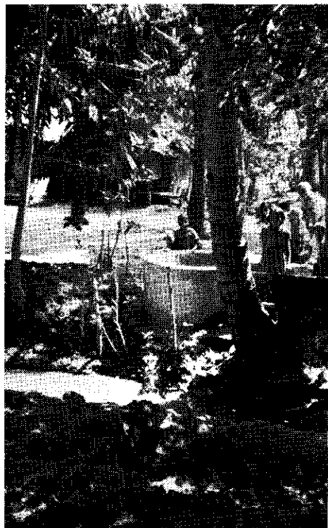
Afb. 6 - Het gereedmaken van de wapening rond de met folie beklede bekisting, die na demontage geschikt blijft voor hergebruik.
