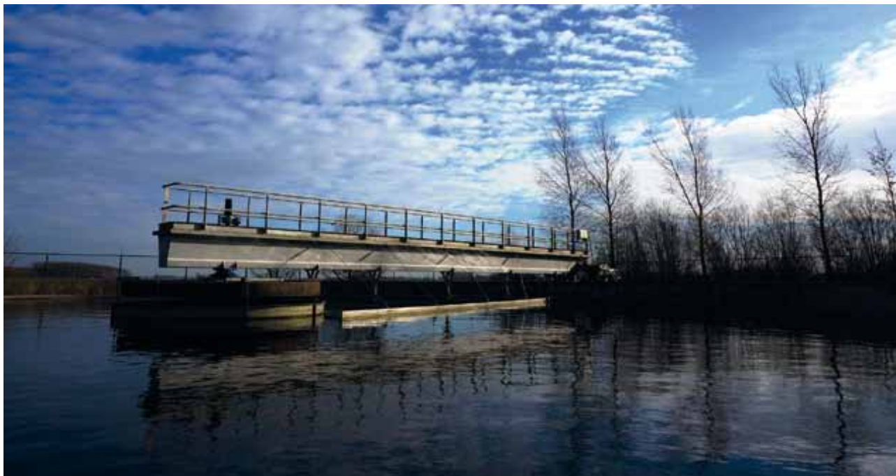
DE RIOOLWATERZUIVERING ULRUM
