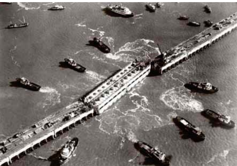
Afsluiting Lauwerszee met de twee laatste caissons, foto Deltadienst 1969
