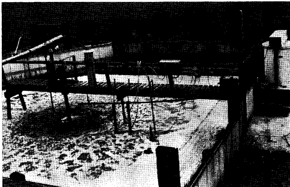
Afb. 2 - Proefinstallatie te Olst met aeratiebassin en kalkdoseringinstallatie.
