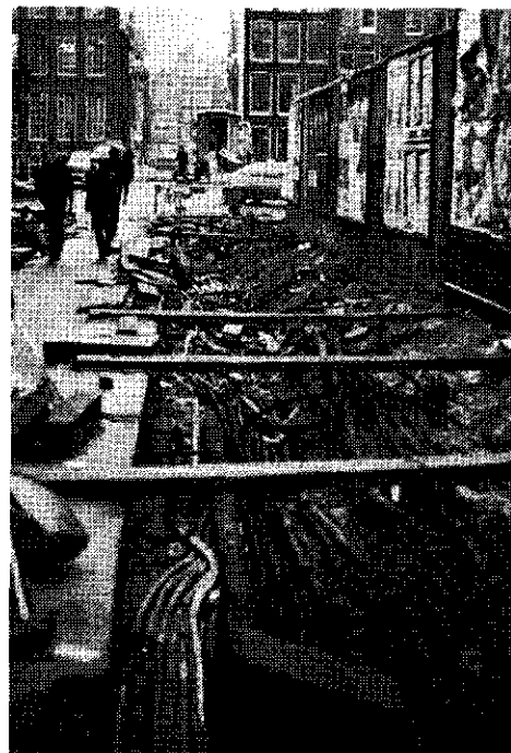
Afb. 4 - Opeenhoping van kabels en leidingen.
