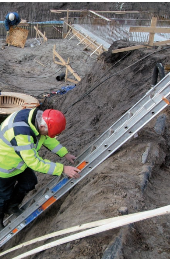
Puurwaterfabriek in aanbouw
