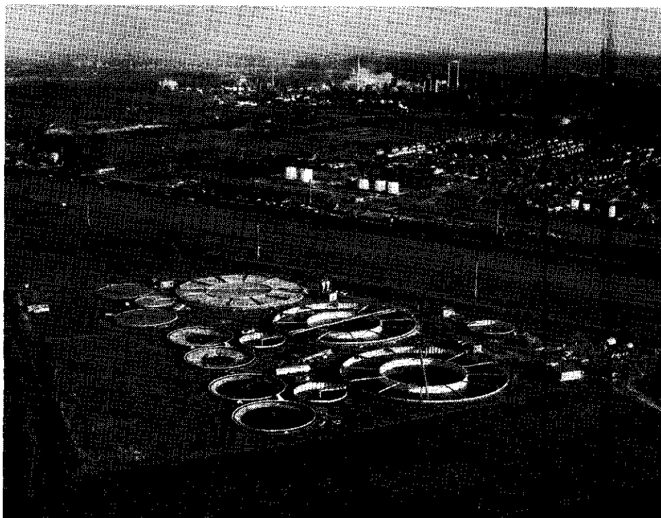
De IAZI in aanbouw. Op de achtergrond de Chemische Bedrijven van DSM.
