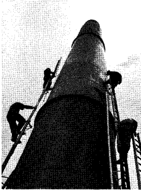
Inspectie van de schoorsteen.
