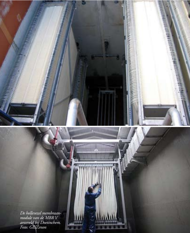
De plaatmembraanmodule van de hybride MBR op rwzi Heenvliet bij Rotterdam. Foto: Waterschap Hollandse Delta
