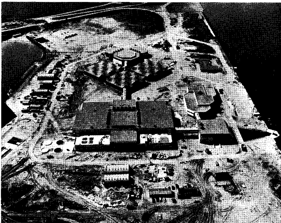
Afb. 2 - Pompstation Enkhuizen van de WRK in aanbouw.
