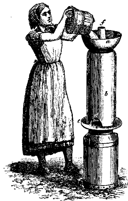
Fig. 124. Melkkoeler en -uitluchter volgens Böggild.
