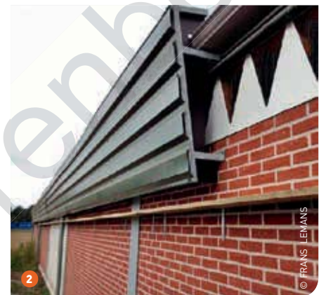
1 Haaiantandprofiel in combinatie met een gordijn, waardoor de netto-opening kan worden aangepast. 2 Detail van het haaiantandprofiel.
