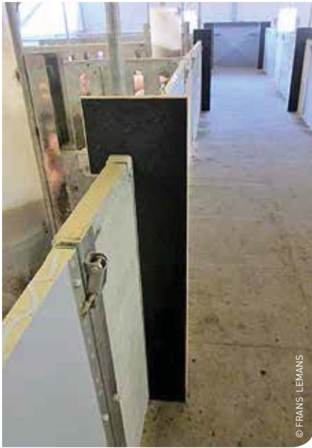
Schotjes in de gang bij deurventilatie.
