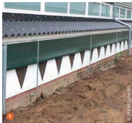
1 Haaiantandprofiel in combinatie met een gordijn, waardoor de netto-opening kan worden aangepast. 2 Detail van het haaiantandprofiel.
